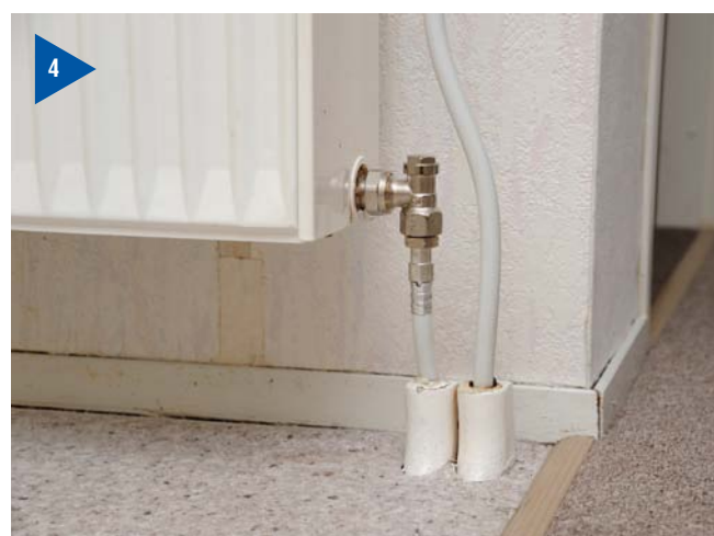
NIEUWE SITUATIE MET NIEUWE RADIATOR, UPONOR MEERLAGENLEIDING, OVENTROP COMBI 4 VOETVENTIEL EN UPONOR MLC PERSFITTING.
