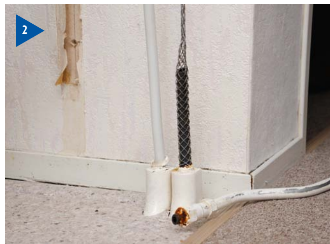
SITUATIE WAARBIJ RADIATOR REEDS VERWIJDERD IS. DE LINKERLEIDING IS REEDS VERVANGEN DOOR EEN UPONOR MEERLAGENLEIDING EN DE RECHTERLEIDING NET UIT DE MANTEL GETROKKEN WORDT.
